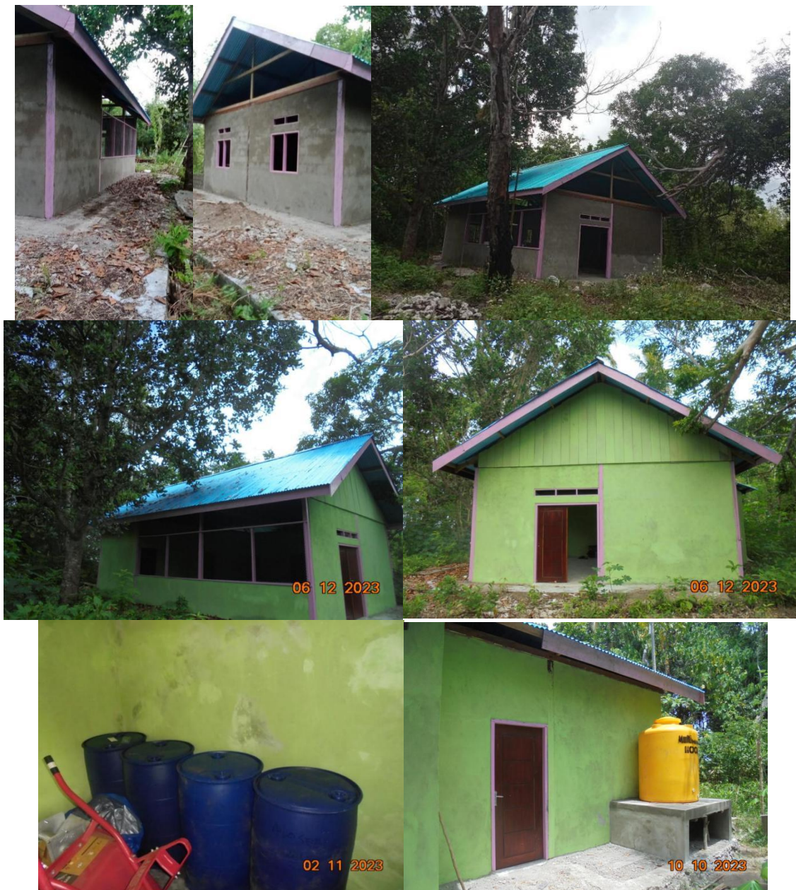
Gambar 39. Dokumentasi Proses Pembangunan Rumah Produksi dan alat-alat pengolahan (sumber foto: S4C LPPM UNIPA)
